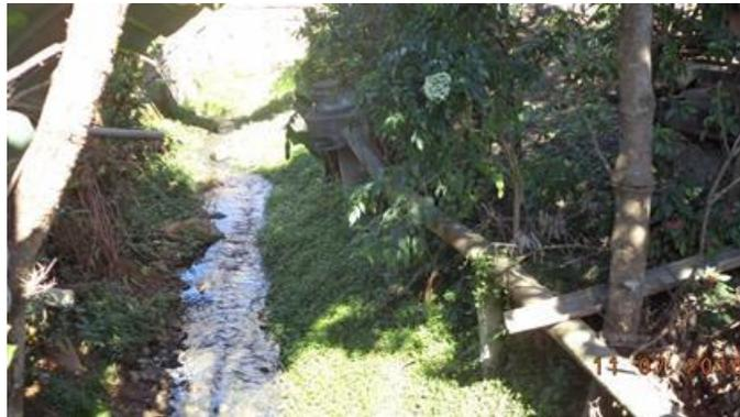
**Figura 6.11 – Trecho danificado, PV e tubulação deslocados.**
