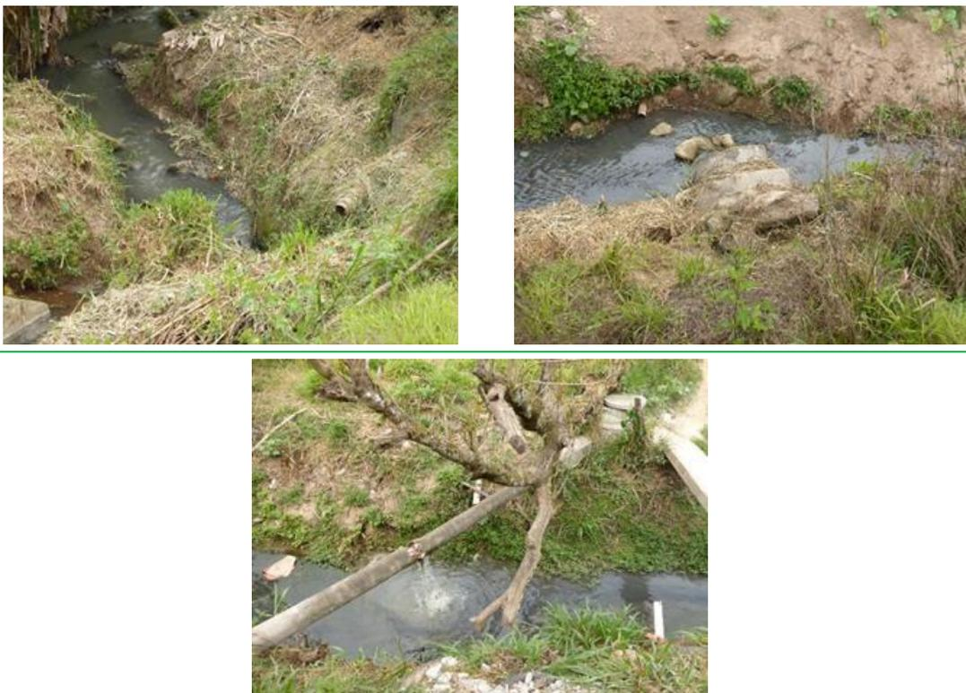
**Figura 6.10 – Tubulação danificada, PV quebrado e travessia danificada, respectivamente.**
