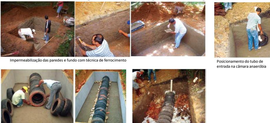
Impermeabilização das paredes e fundo com técnica de ferrocimento
