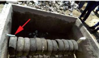
Tubo ladrão ligado à sumidouro ou vala de infiltração
