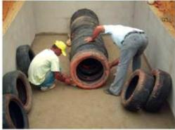
Construção da câmara anaeróbia: duto em pneus
