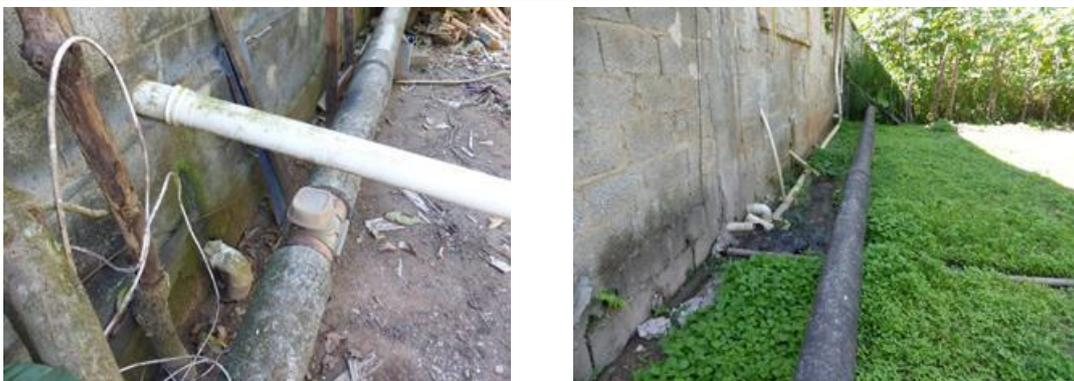
**Figura 6.1 – Ausência de ligação de edificação lindeira ao Interceptor Criminoso.**
