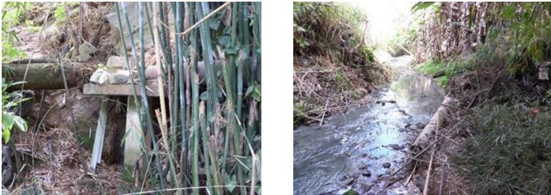
**Figura 6.9 – Muro caído sobre PV e tubulação caída no córrego, respectivamente.**
