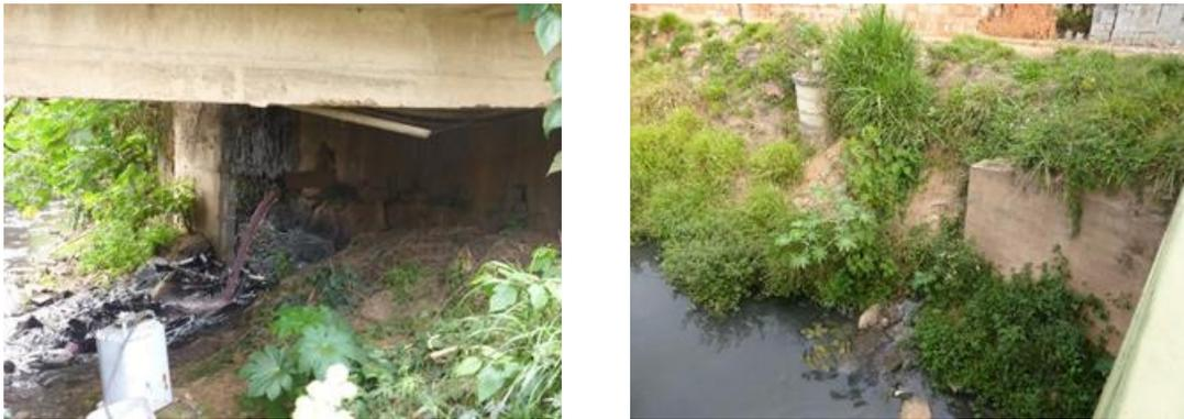
**Figura 6.3 – Lançamento de esgoto in natura na margem direita e PV03 para interligar o lançamento, respectivamente.**
