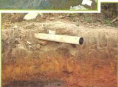
Imagem 3: Tubo de entrada de esgoto
