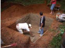
Impermeabilização das paredes e fundo com técnica de ferrocimento
