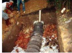
Preenchimento da câmara com entulhos de construção: cacos cerâmicos, tijolos, pedras, etc.
